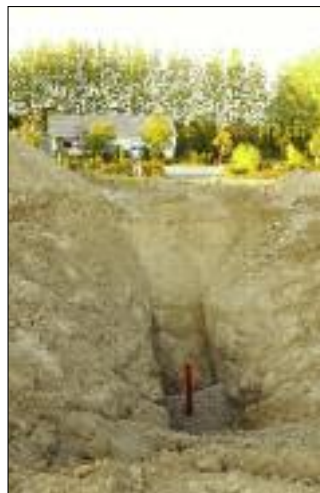
Gravearbejder ved Silkeborgvej i forbindelse med kloakseparering
