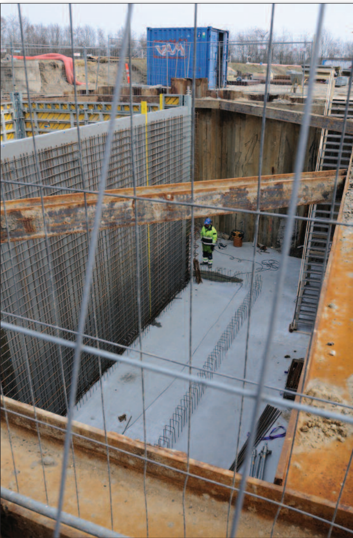
Det nye kloakanlæg går i dybden
