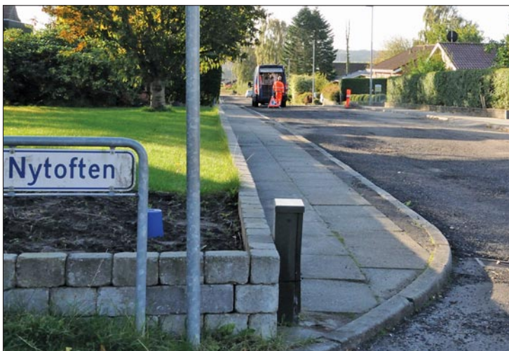
Nyvangsvej så sådan ud under kloakeringsarbejdet
