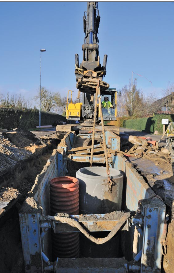
Kloakarbejdet i fuld gang på Kettingvej
