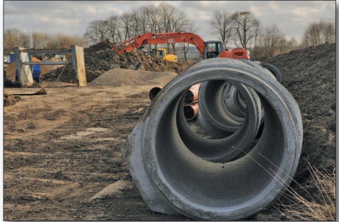
Nye hovedledninger klar til nedlægning
