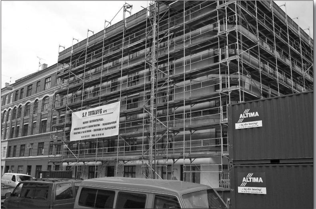
Facaderenovering, nyt tag m.v. på en ejendom i Lombardigade i København
