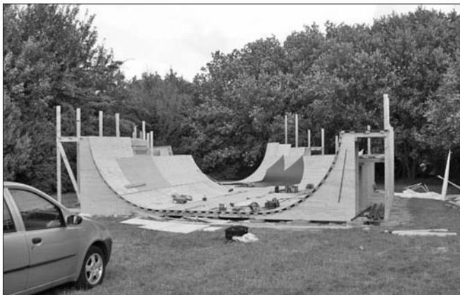
Skaterbanen under opbygning.
