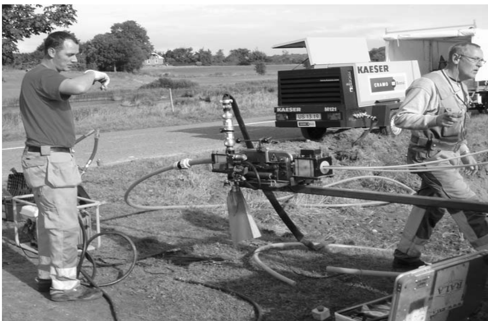
Billeder af en fiberledning der nedlægges.
