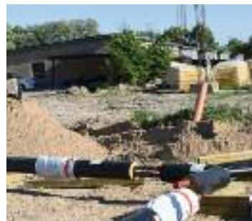
Her er der gang i ledningsarbejdet på Hyldahls grund
