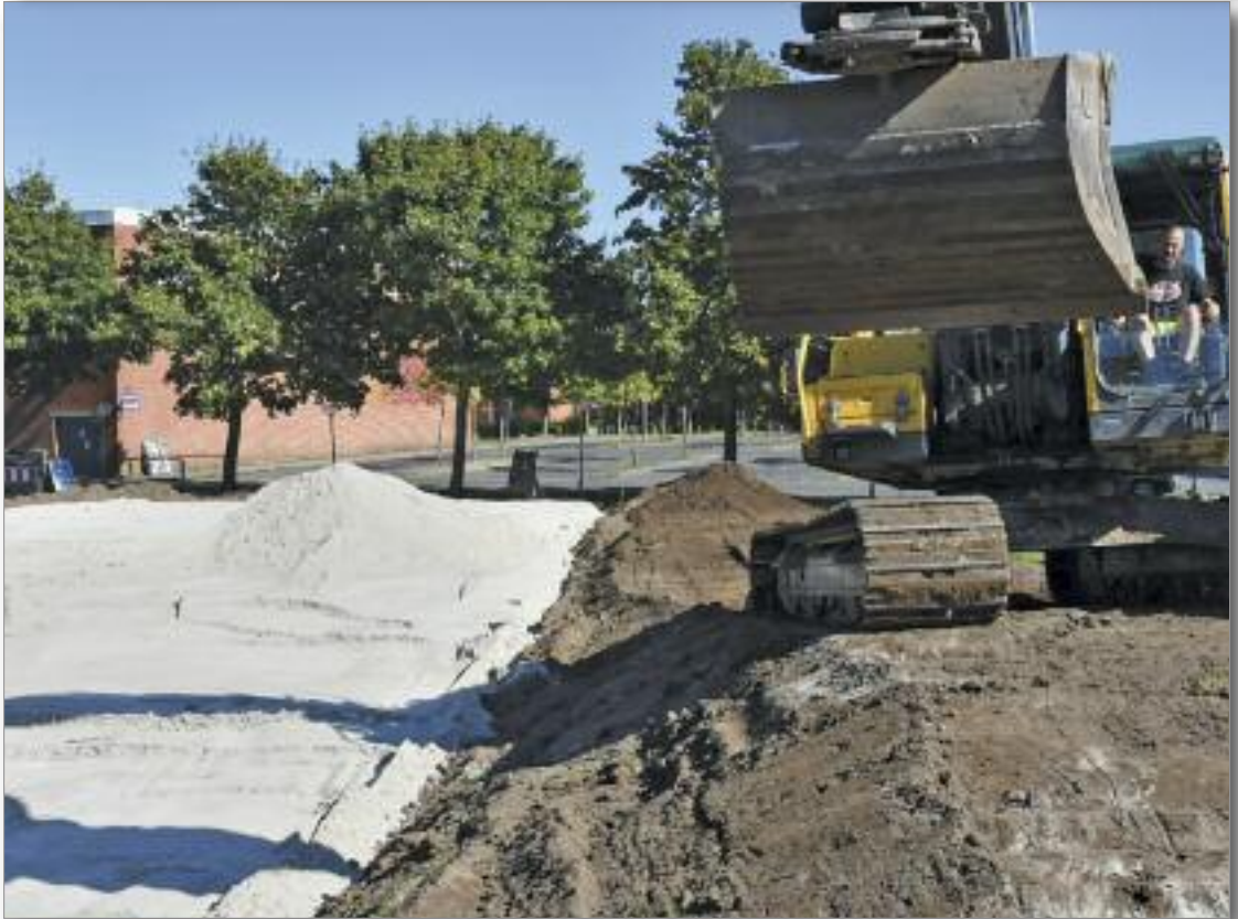
Sandbanen i færd med at blive etableret
